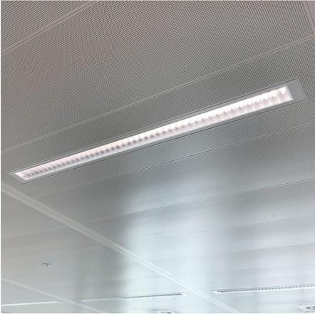
Un luminaire linéaire avec grille parabolique pour application dans les plafonds climatiques et métalliques.
