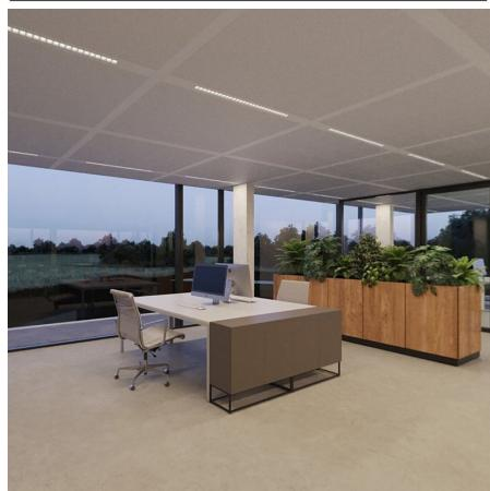
Metronome-K est un luminaire LED linéaire équipé de 20, 28 ou 36 lentilles, encastrées derrière un déflecteur en forme de grille. Ce luminaire LED est une solution d'éclairage entièrement nouvelle pour un éclairage efficace avec une esthétique architecturale. Il est possible de choisir entre des optiques UGR< 19 (standard) et UGR< 16.
