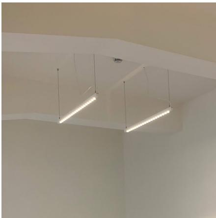
Sirio-S white est un luminaire LED suspendu élégant et fin équipé d'une rangée de LED mid-power, chacune avec une lentille et un déflecteur individuels.
